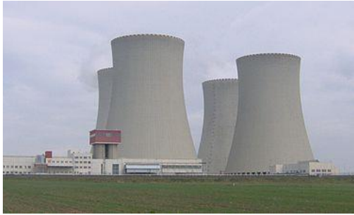
Chladicí věže Jaderné elektrárny Temelín
